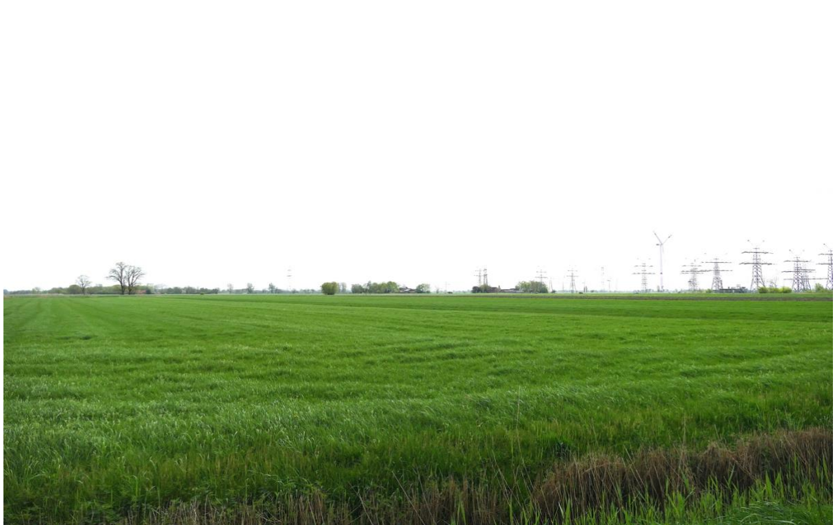
Blick in süd-östlicher Richtung, im Hintergrund die Schaltanlage Elsfleth
